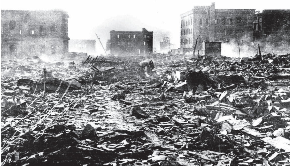
岸田貢宣 8月7日朝、破壊された本通りから西を見る (広島平和記念資料館提供)
