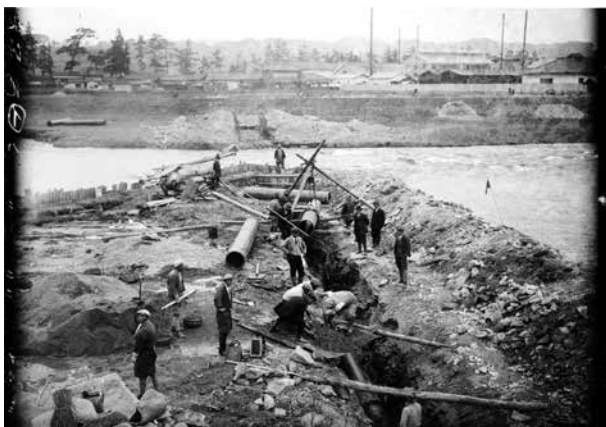
郡是～吉井川横断排水管敷設 昭和7～8年
